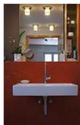
Lehmputz im Bad
