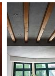
Balkendecke mit Lehmputz
