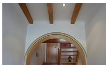
Diele mit restauriertem Stuckbogen und Lehmputz
