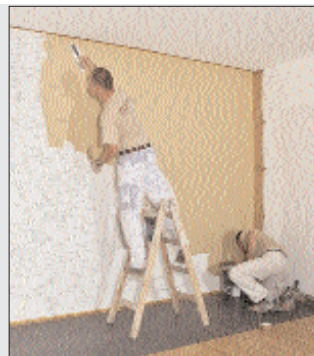
Aufbringen des dünnlagigen Lehmputzes - W. Scheeres und Mitarbeiter
